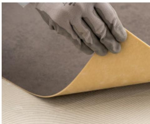
Colocación de suelos de poliuretano con Ultrabond Eco V4 Evolution
