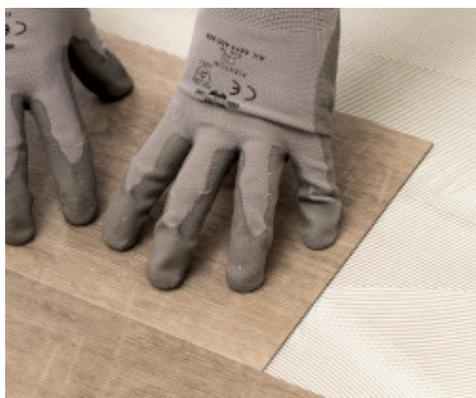
Colocación de LVT con Ultrabond Eco V4 Evolution
