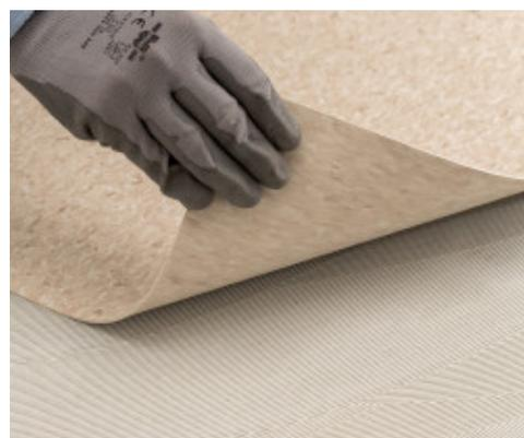
Colocación de PVC homogéneo con Ultrabond Eco V4 Evolution
