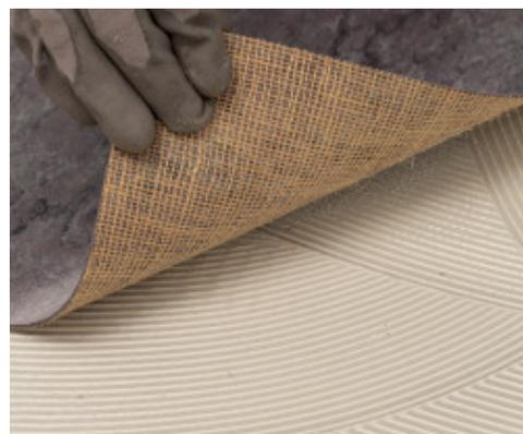
Colocación de linóleo con Ultrabond Eco V4 Evolution
