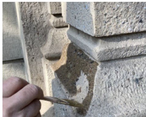
Consolidación de elemento arquitectónico con Primer 3296 aplicado a brocha
