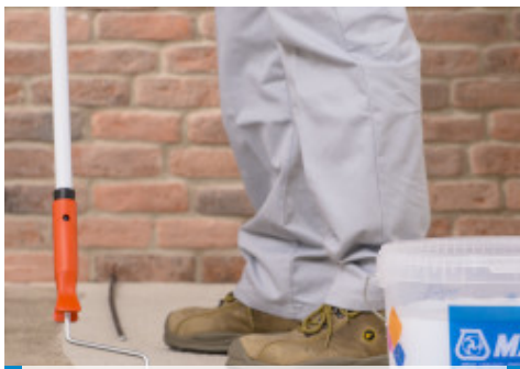
Extendido de Primer 3296 como preparación del soporte en el refuerzo de forjados de bovedilla cerámica y vigueta de hormigón con Planitop HPC Floor
