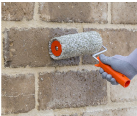
Aplicación de Primer 3296 a rodillo sobre albañilería de tufo
