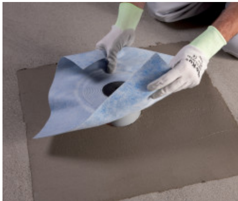
Colocación de Drain Vertical, cazoleta de sumidero, sobre Mapelastic
