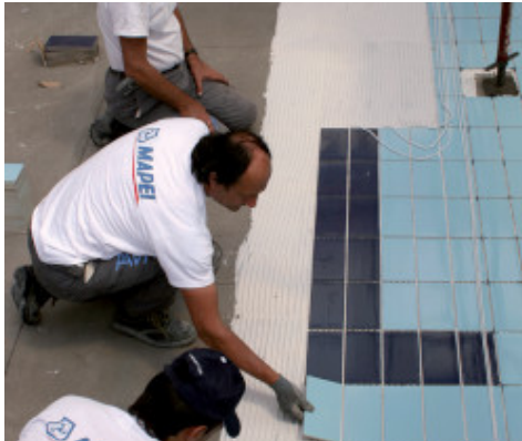
Colocación de revestimiento cerámico sobre Mapelastic
