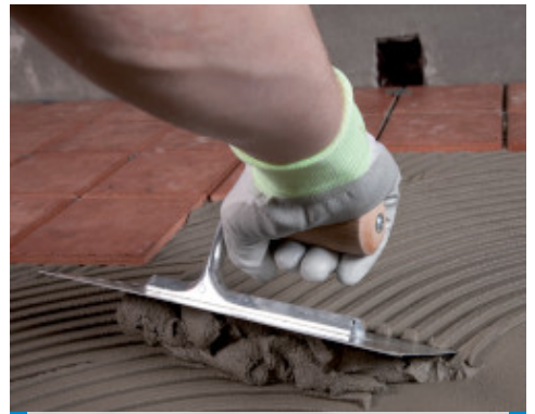
Colocación de Granirapid sobre terraza impermeabilizada con Mapelastic
