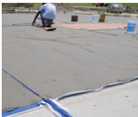
Impermeabilización de los recrecidos con Mapelastick y Mapeband
