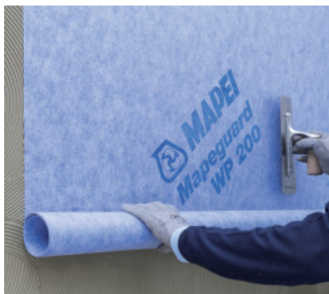
Instalación de Mapeguard WP 200
