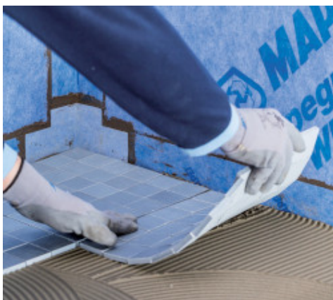
Instalación de cerámica
