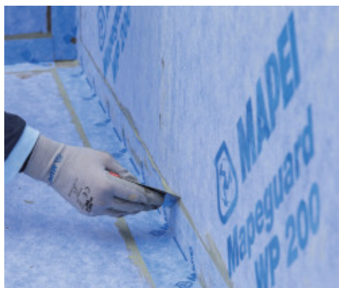
Aplicación de bandas tipo Mapeguard ST
