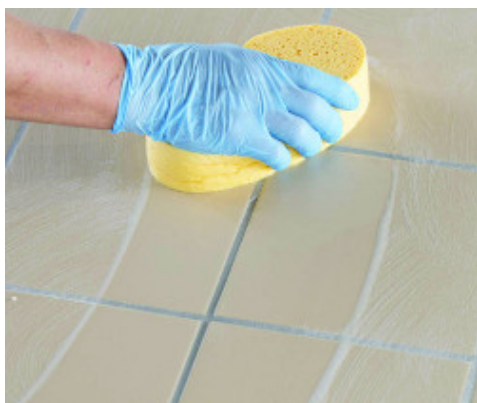
Limpieza y acabado de la junta con esponja de celulosa dura
