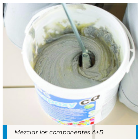
Verter el endurecedor (componente B) en el envase del componente A
