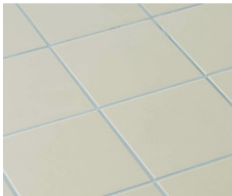
Pavimento final rejuntado con Kerapoxy CQ
